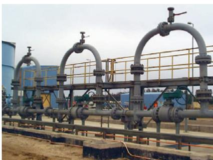
*Estas válvulas de cobre para lodo clase ASME 900 de 8 pulgadas funcionan sin fallas desde 1999, con 40 ciclos por mes a 1500 psi.*
