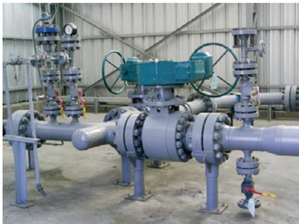
*Esta estación de bombeo de hidrotransporte tiene válvulas de bola con asiento metálico clase ASME 1500 de 6 y 8 pulgadas, como también numerosas válvulas de drenaje clase ASME 1500 de 2 pulgadas, que operan desde 1994 sin reparación.*
